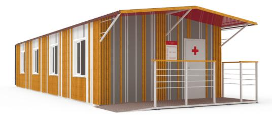
Кракас: Металлический конструкция, сендвич панели. Обшивка: деревом хвойных пород
